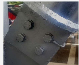
공단에 설치된 태양광 (용융아연도금된 구조물)
